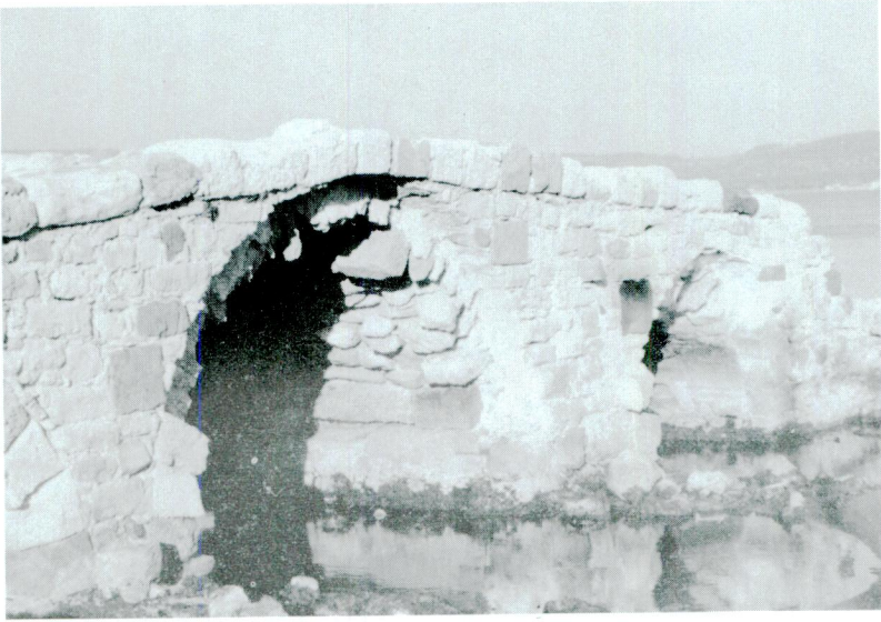
Res. 10 – Köprünün 1989 başındaki durumu
