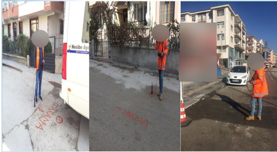
Şekil 5. Gürültü kaydedicilerden sonra yer mikrofonu ile şebeke boru üzerinde fiziki kayıp noktası arama.
