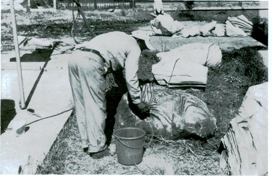
Res. 20 — Su kullanarak kırık yüzeylerin temizlenmesi.
