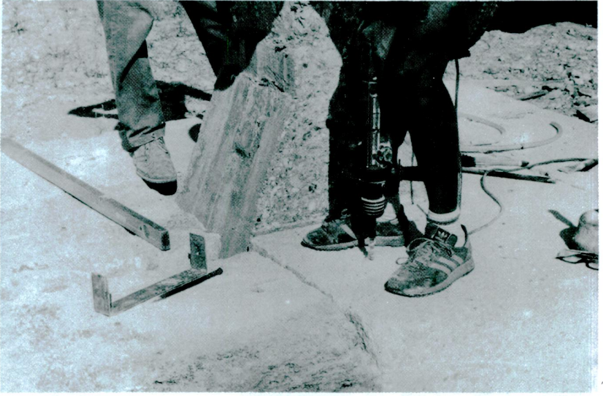
Res. 39a — Kenet yuvalarının açılması.
