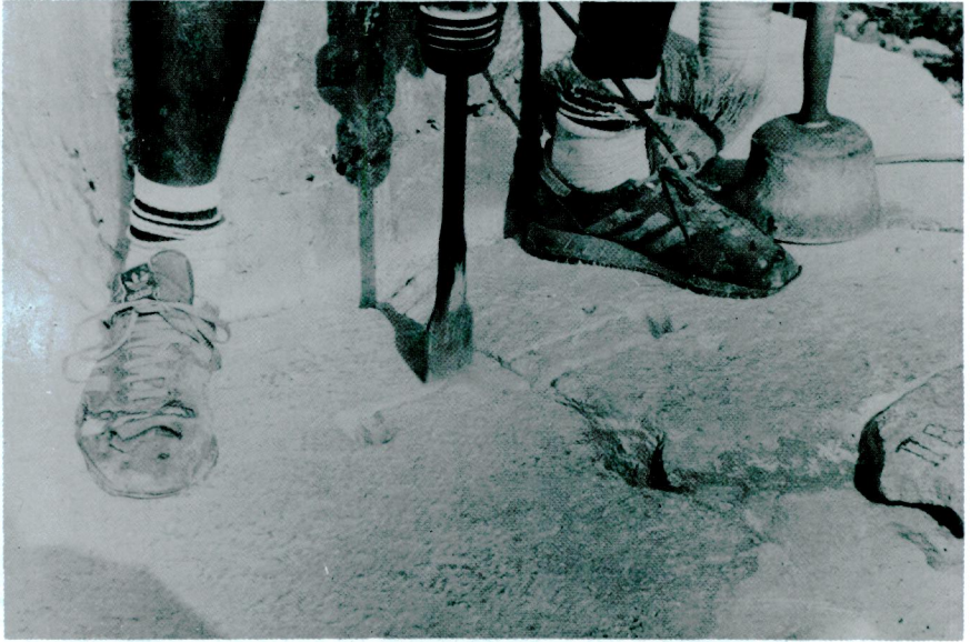
Res. 39b — Kenet yuvasının kenarlarının sınırlandırılması.
