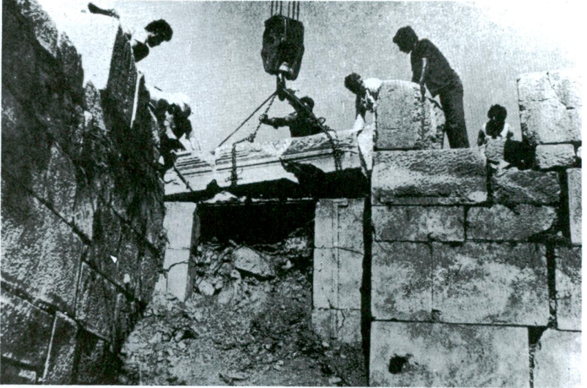
Res. 8 — Onarılan leatonun tamamen açığa çıkarılmamış şöveler üzerine oturtulması (Bayburtluođlu'ndan).
