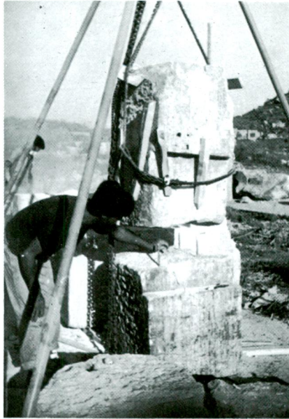
Res. 24 — Metal çubuk kullanarak iki parçanın birleştirilmesi.
