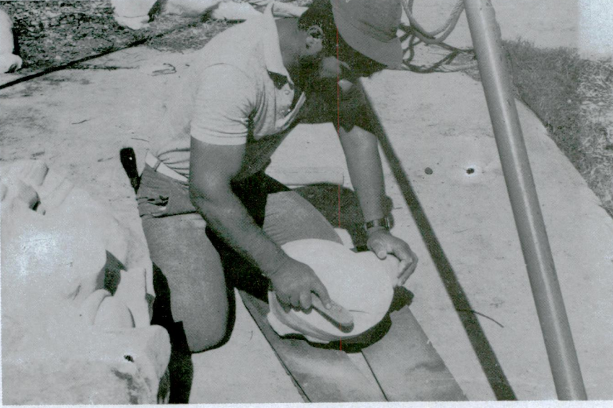
Res. 21 — Çelik tel fırçayla kırık yüzeyin temizlenmesi.
