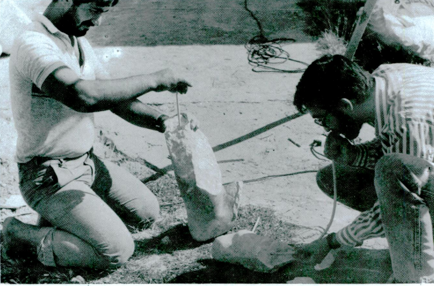
Res. 37 — Kıvrılabilen hortum kullanılarak delik içinin temizlenmesi.
