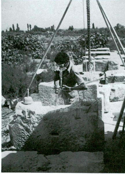
Res. 5 — Beton kolon geçirileceđi düşüncesiyle ortasının oyulması.
