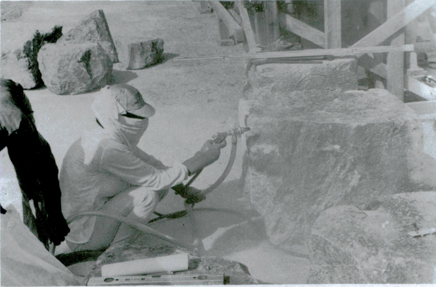
Res. 22 — Basınçlı kum püskürtülerek kırık yüzeyin temizlenmesi.
