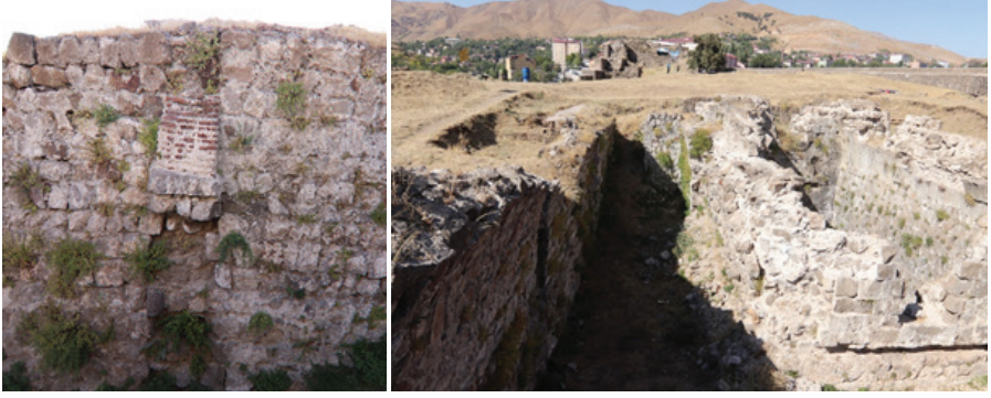
Görsel 15. Bitlis Sinan Bey (Kale) Hamamı Batı Cephesi ve Su Depoları
