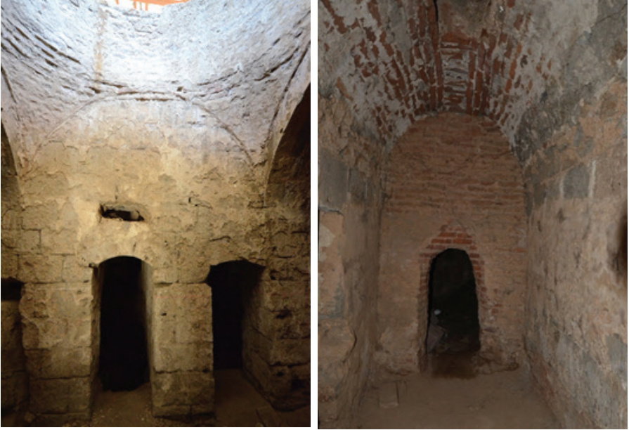
Görsel 5. Bitlis Sinan Bey (Kale) Hamamı Üst örtü ve Kubbeye Geçiş Elemanları
