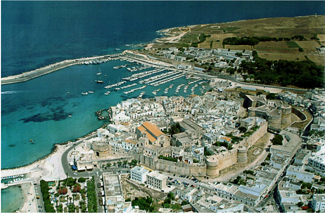
Fig. 4. Otranto. İspanyol Dönemi'ne ait yerleşim, surlar ve kalenin havadan görünümü (16. yüzyıl)
