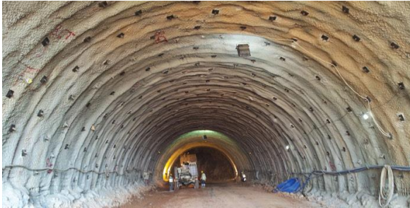
Şekil 7. Püskürtme beton kullanılan bir tünel inşaatı (URL-6, 2015)
