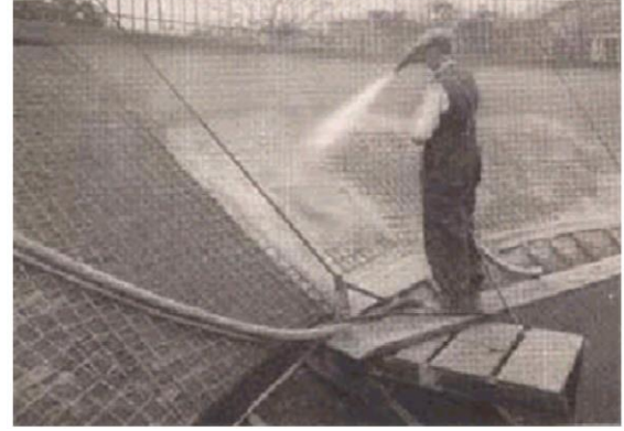
Şekil 2. 1919'da Pittsburgh'daki bir su deposu için püskürtme harcı uygulayan hortumcu (Yoggy, 2000)
