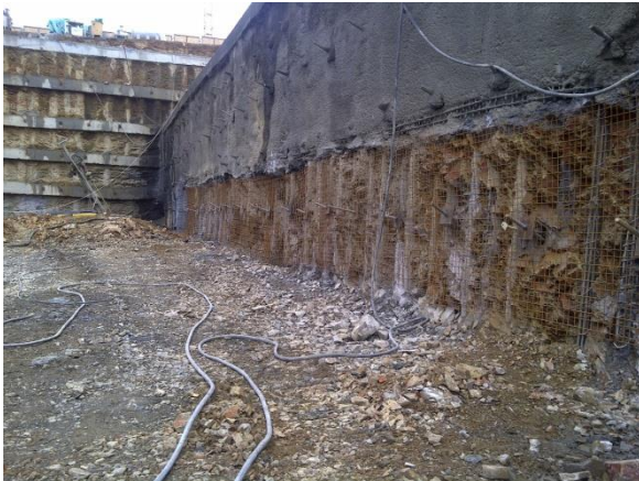
Şekil 8. Püskürtme beton kullanılan bir iksa yapısı
