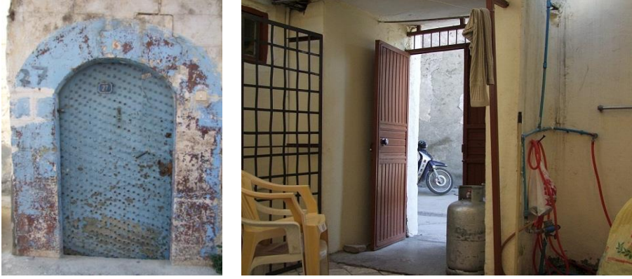
Resim 9 ve 10: Geleneksel Antakya evi kapısı ve yenilenen demir kapı
