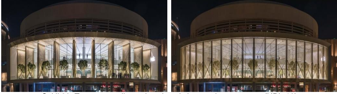
Şekil 20: Terasta paneller açık ve kapalıyken cephe görünümü (URL-10)
