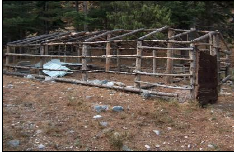
Foto 7: Elmaliboğaz vadisi içerisinde çıkış ve inişlerde kullanılan yayla evi çatması
