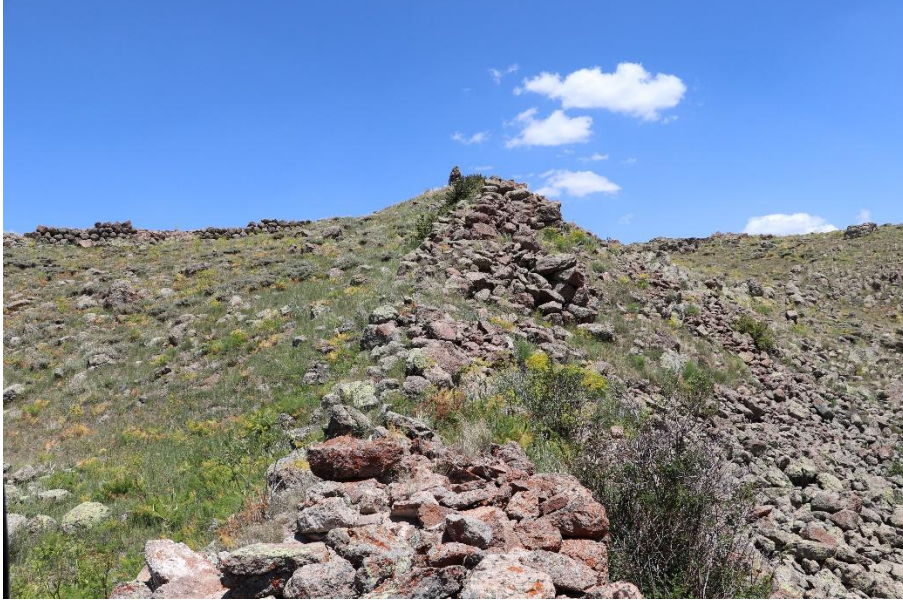
Fotoğraf 11: Pırtın Kalesi Yıkılmış Durumda Olan Sur Duvarları
