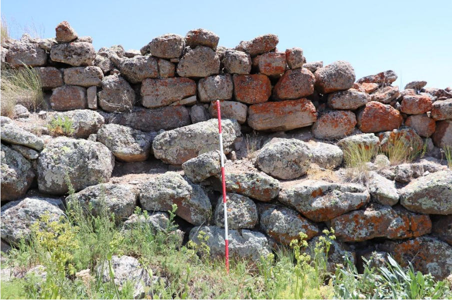
Fotoğraf 7: Pırtın Kalesi Doğu Sur Duvarı
