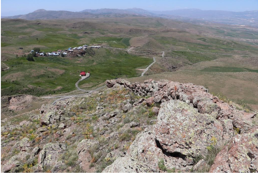
Fotoğraf 12: Pırtın Kalesi Sur Duvarı
