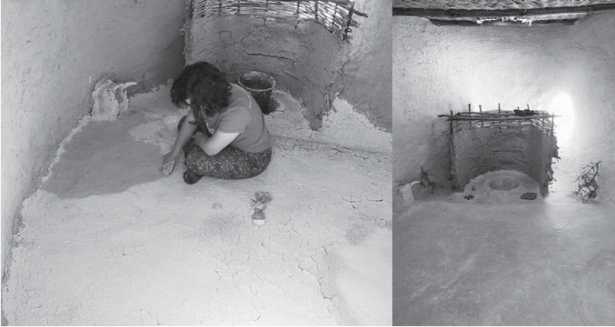
Levha 10: Taban sıvası üzerinde perdahlama tekniğinin kullanımı.
