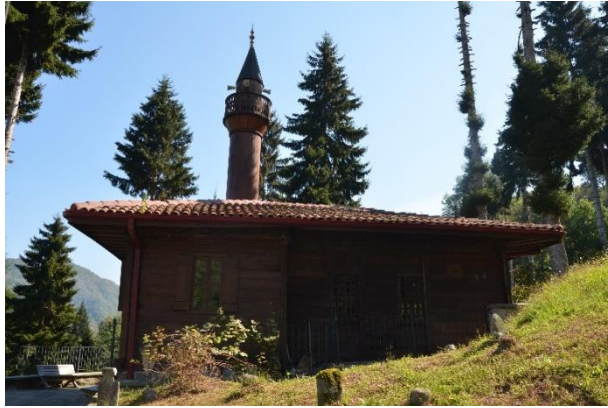
Görsel 7. Bereketli Mahallesi Masele Camii Batı Cephe
