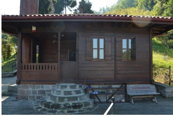
Görsel 4. Bereketli Mahallesi Masele Camii Kuzey Cephe
