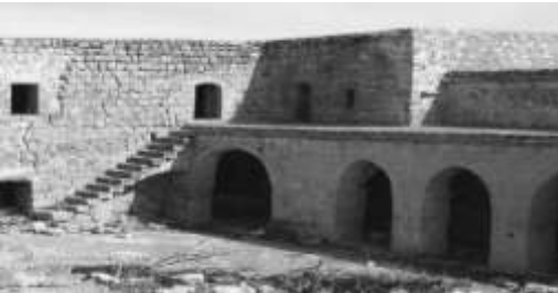
Resim 4. Kesme taştan yapılmış merdiven
