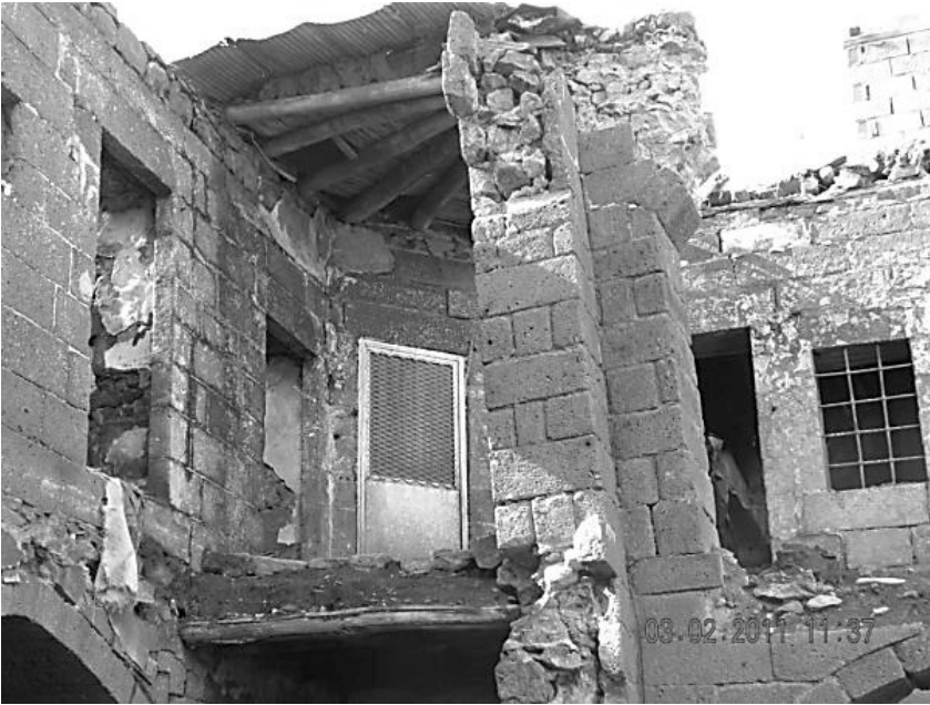
Fotoğraf 12. Çifte Han Revak Örtü Sistemi Detayı.
