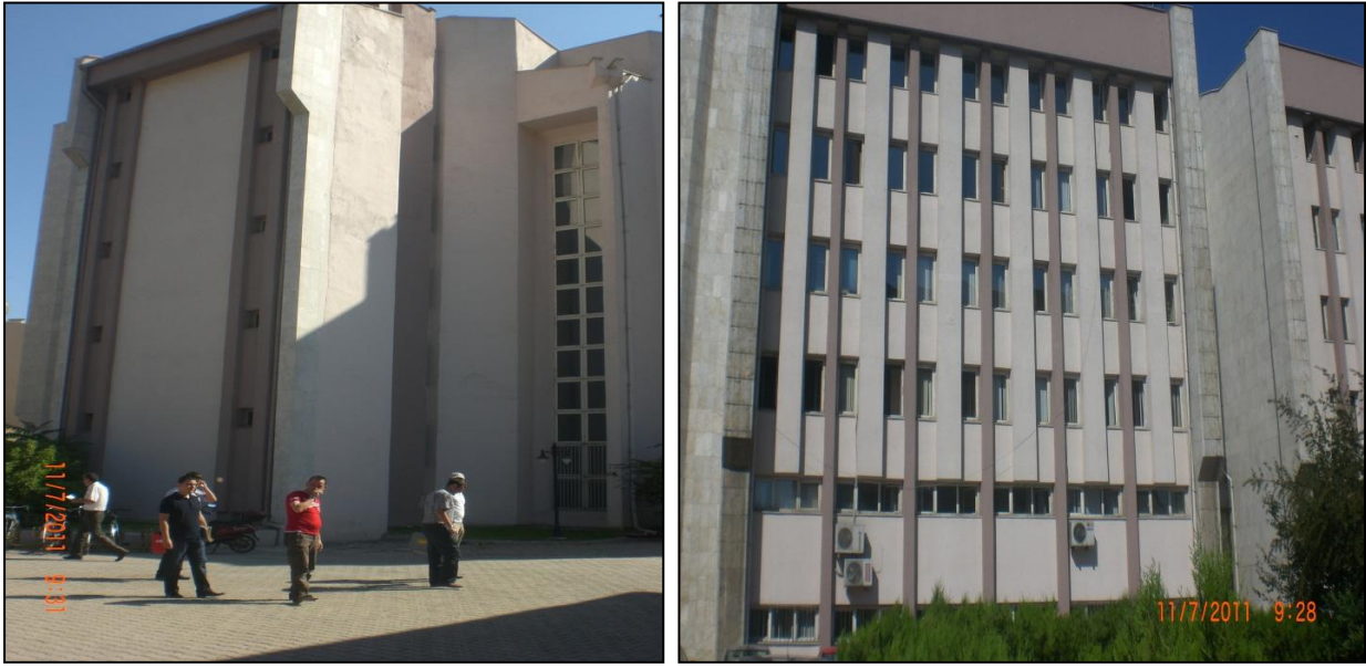
Şekil 1. Hükümet Konağı Binasının H1 ve H3 bloklarının önden ve arkadan görünüşü
