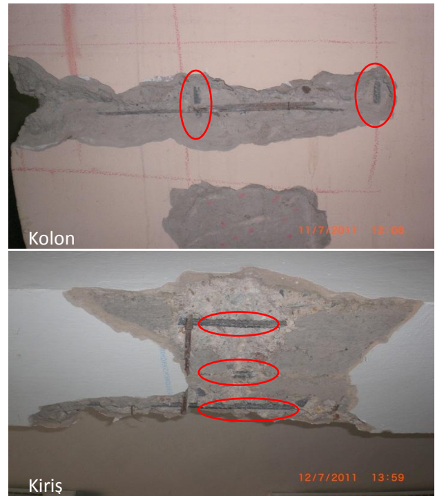
Şekil 4. Betonarme elemanlarda donatı tespiti
