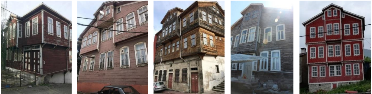
Şekil 12. Geleneksel konut dokusunda yer alan yapıların cephelerinden örnekler
