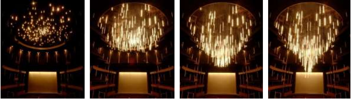
Şekil 20. Tavandan asılı durumda olan ve kotları değişebilen aydınlatma elemanları (URL-10)
