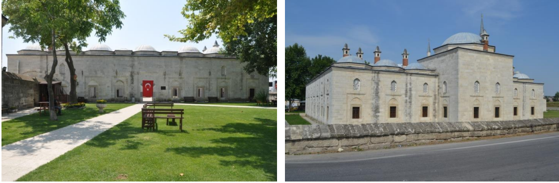
Şekil 11;12. Kuzeydoğu cephesi; Güneybatı cephesi (Benian ve Mısırlı, 2018)
