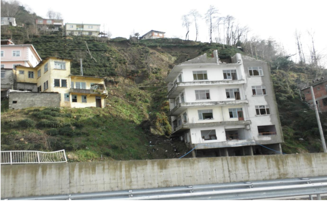
Photo 7. Inclined and Steep Slopes have Caused Landslides in Rize (Gündoğdu-2010). Photo: İlhan Turan (Fotoğraf 7. Eğimli ve dik yamaçlar Rize'de toprak kaymalarına neden olmaktadır)
