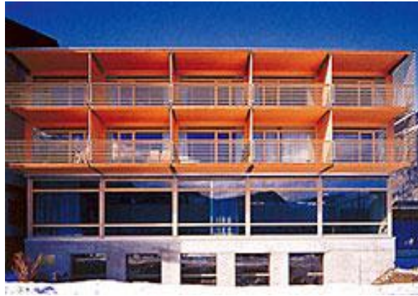
Şekil 21. Post Otel binası [4] (Figure 21. Post Hotel building)
