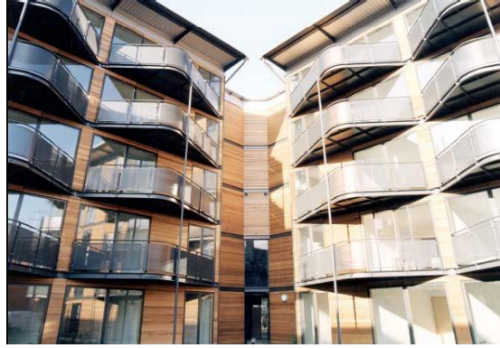
Şekil 20. Murray Grove Konutları terekota kaplama cephesi [20] (Figure 20. Murray Grove Housing façade using terracotta tiles)
