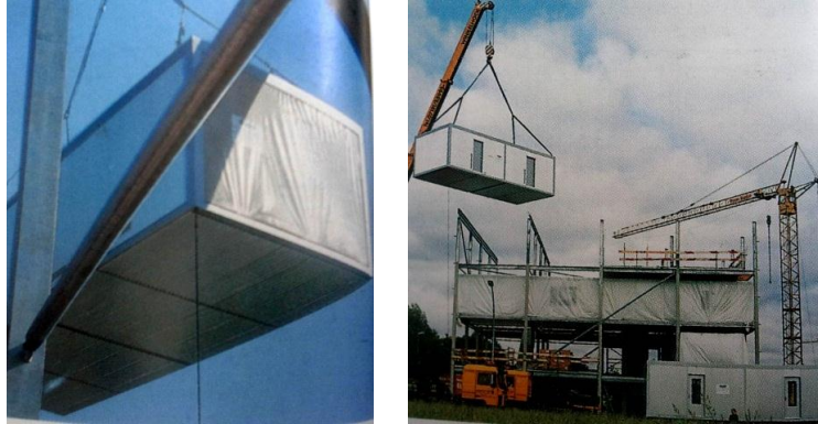
Şekil 15. Modüllerin iskelet sisteme montajı [4] (Figure 15. Modul installation into frame system)
