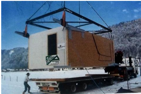
Şekil 13. Yığma yapı modül kutu sistem uygulanması [4] (Figure 13. Construction of structural masonry modular box system)
