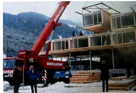
Şekil 13. Yığma yapı modül kutu sistem uygulanması [4] (Figure 13. Construction of structural masonry modular box system)
