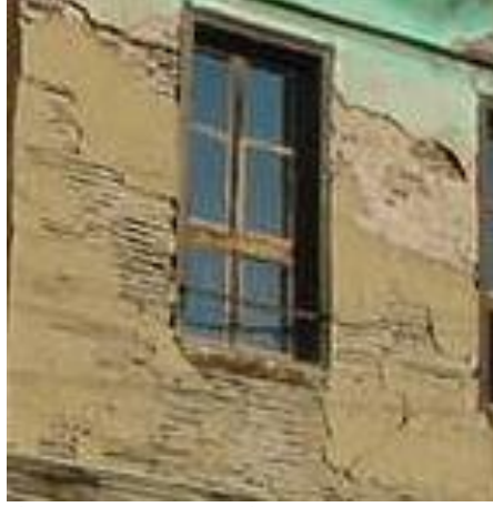
Şekil 14. Bağdadi kaplamalı duvar (Figure 14. Bağdadi wall covering)
