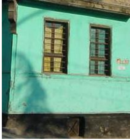
Şekil 15. Sıvalı duvar (Figure 15. Wall with plaster)
