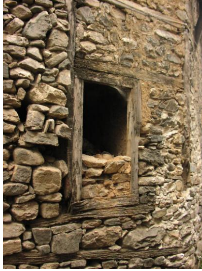
Şekil 6. Taş yığma duvar (Figure 6. Stone block wall)
