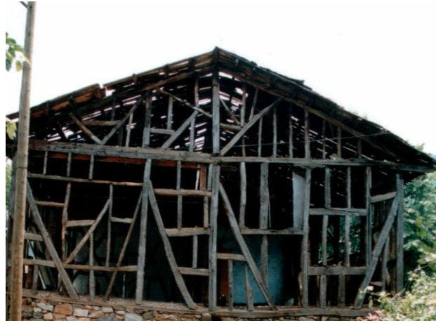
Şekil 9. Ahşap iskelet duvar (Figure 9. Wood frame wall)
