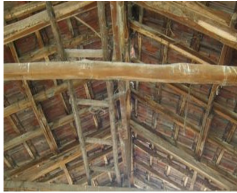
Şekil 21. Çatı (Figure 21. Example of roof)
