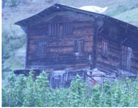
Şekil 8. Ahşap yığma duvar (Figure 8. Wood block wall)
