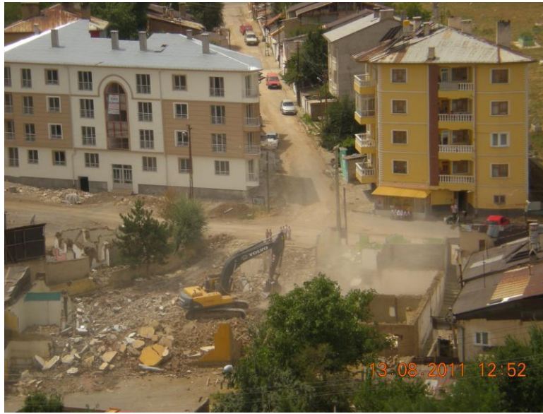
Şekil 1. Sivas'ta tek katlı konutlardan çok katlı binalara geçiş (Figure 1. Transition from one storey residential to high-rise buildings in Sivas)
