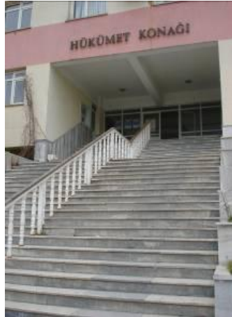
Şekil 15. Yapı girişi (Yozgat Hükümet Konağı)
