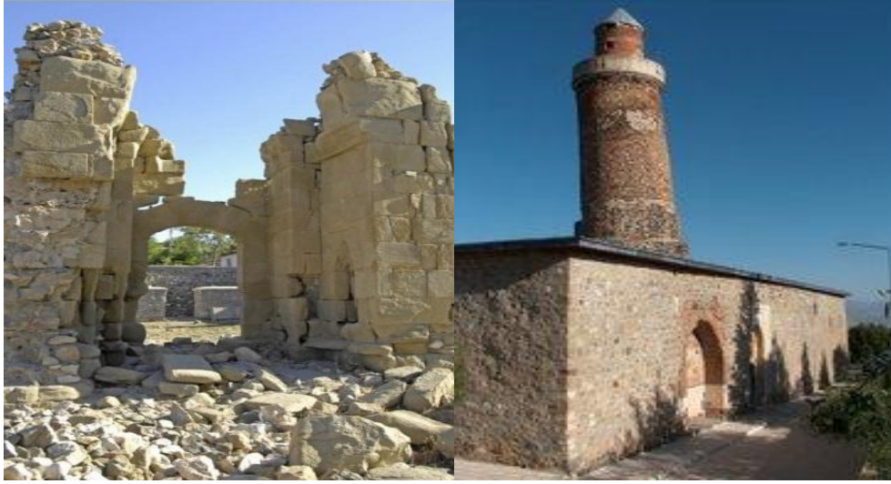
Şekil 5. Harput Esadiye Cami ve Ulu Cami genel görünümü (Figure 5. General view of Harput Esadiye Mosque and Ulu Mosque)
