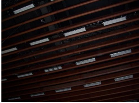
Şekil 30. Orkestra üzerindeki yansıtıcı tavan [Özçetin, Z. arşivi] (Figure 30. Reflective roof on the orchestral) [Özçetin,Z. archive]
