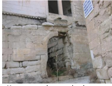
Yapının kuzeyinde yer alan avlu
