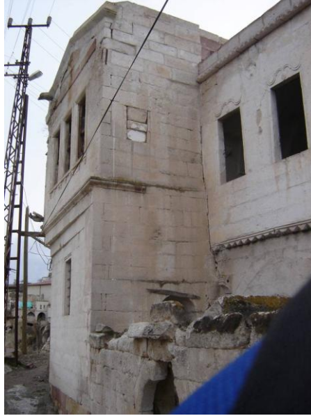
Şekil 5. Yapının doğu cephesi (Figure 5. East side of the building)
