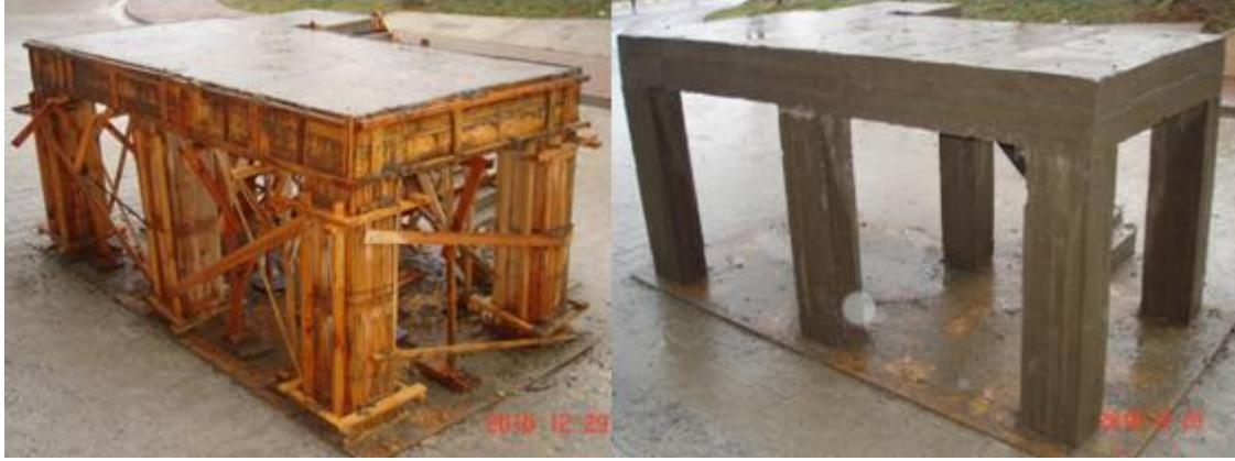
Şekil 2. Örnek Yapının inşa aşamaları (Figure 2. Construction stages of example building)
