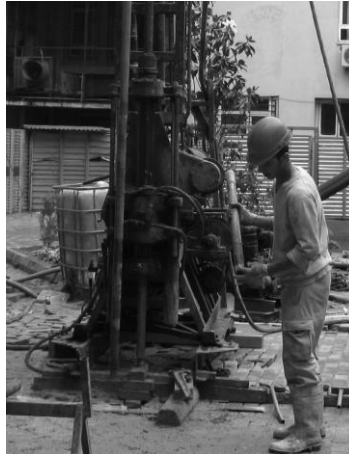
Şekil 9. Çimento şerbeti enjeksiyonu (Figure 9. Cement grout injection)
