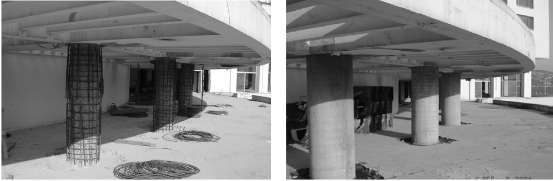
Figure 4. Jacketing existing columns (Resim 4. Kolonların mantolanması) (DO-KA/Tuncel/EPS, 2003)
