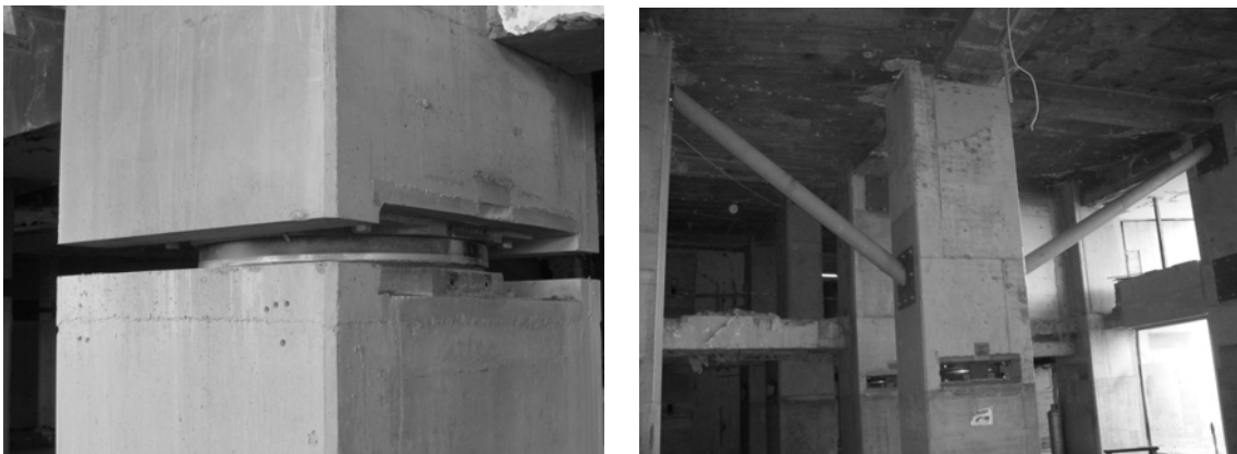
Figure 5. Isolator system and steel braces (Resim 5. İsolatör sistemi ve çelik kuşaklar) (DO-KA/Tuncel/EPS, 2003)
