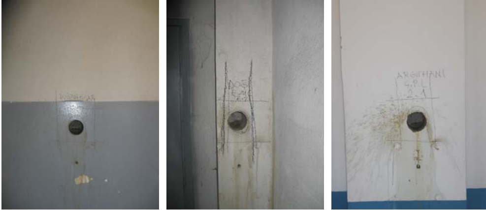
Şekil 7. DEML ve AMEVÇPL'ye ait karot numune alımı (Figure 7. Obtaining drilling core sample from DEML and AMEVÇPL)
