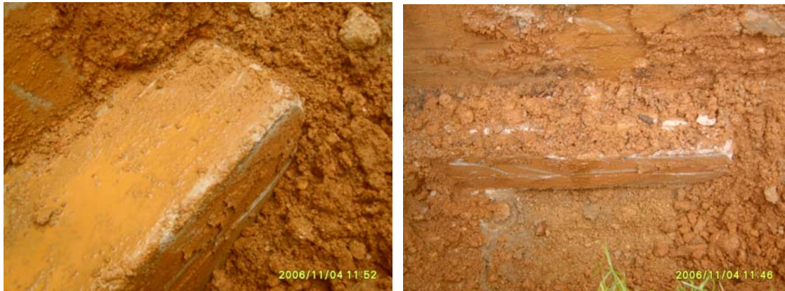
Şekil 6. DEML temel araştırmaları görüntüsü (Figure 6. Foundation investigation image of DEML)
