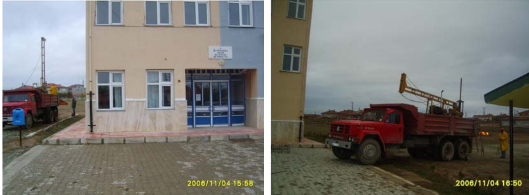
Şekil 5. AMEVÇPL’de yapılan zemin etüt çalışmalarından görüntü (Figure 5. Ground research image of AMEVÇPL)
