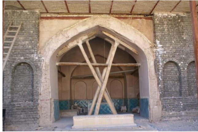
Fotoğraf 4. Mezarların Bulunduğu Eyvan Onarım Sırasında
