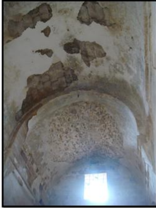
Şekil 24. Sağ nefte tonozlar arasındaki örgü farklılığı (Figure 24. System the difference between the right nave vaults)
