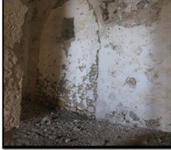
Şekil 20. Papaz hazırlık odasının nefe bakan kapatılmış kemeri (Figure 20. The priest closed the preparation room overlooking the nave arch)
