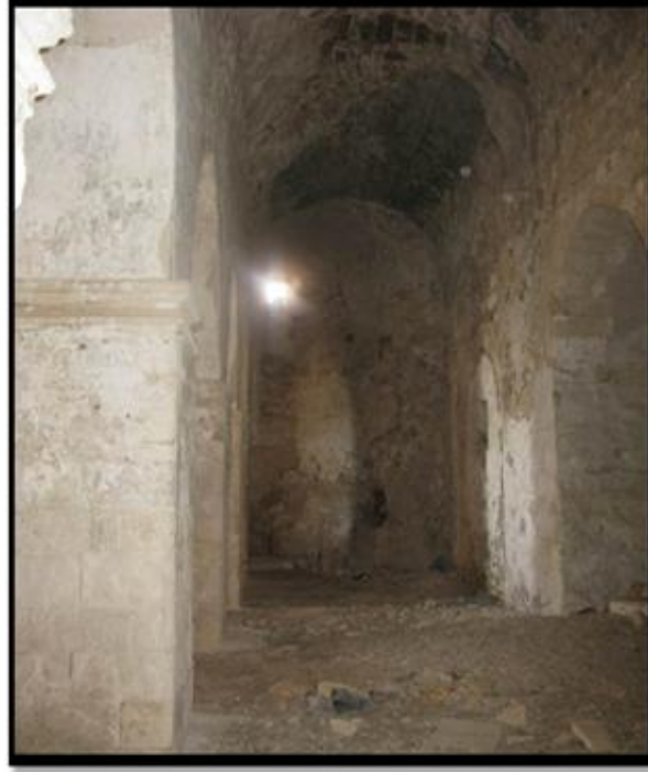
Şekil 16. Apsisten sağ nef bakiş (Figure 16. View of the rigth nave apse)
