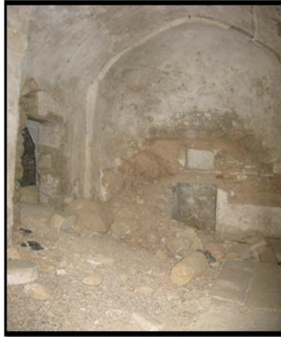
Şekil 17. Vaftizhane ve papaz bölümüne açılan hol (Figure 17. Section of the Baptistry and the priest opened hall)
