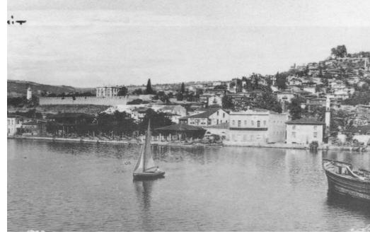
Resim 10. Gümrük Binası, İskele (Figure 10. Customs House, Pier)
