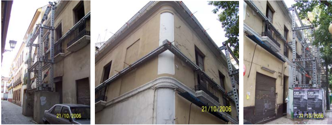
Resim 12. Binaların restorasyonu ve iskele işi (Picture 12. Restoration of buildings and dead work)
