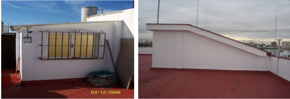
Resim 20. Teras çatı uygulaması-yalıtım (Picture 20. Application of terrace-insulation)
