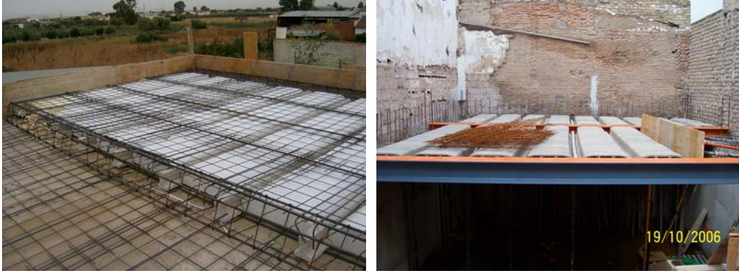
Resim 11. Asmolen döşemede çelik profil uygulamaları (Picture 11. Application of reinforcement to floors)
