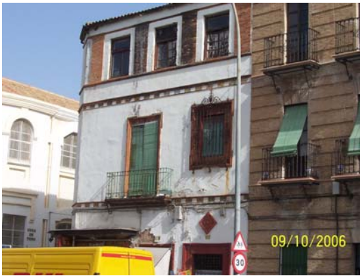
Resim 26. Konutlarda meydana gelen hasarlar (Picture 26. Structural damages at the outwalls)
