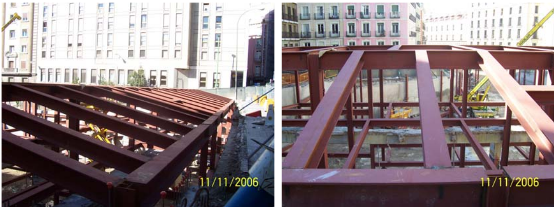
Resim 10. Madrid'de Yapılan Çelik Yapı Çalışması (Picture 10. Contracture of steel structure in Madrid)
