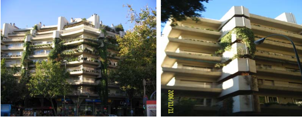
Resim 17. Bina ve çevre ilişkisi (Picture 17. Relation of building and environmental)
