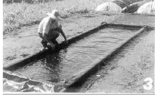
Şekil 3.3. Havuz içine siyah naylon serilmesi
