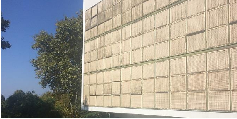
Şekil 31. Turgut Cansever ve Abdurrahman Hancı, Anadolu Kulübü Binası, İstanbul, 1957 (Enes Uyar, 2019)
