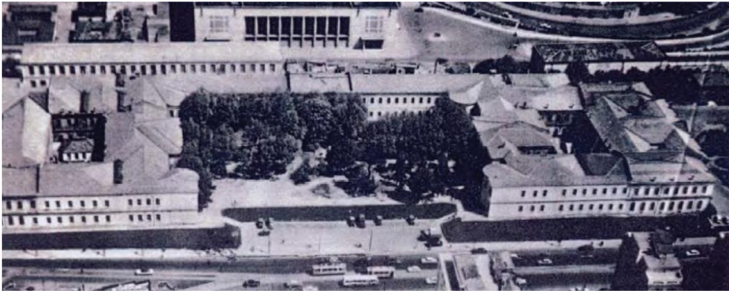
Şekil 6. 1959 yılındaki yıkımdan sonra avlunun caddeye açılmış hali (Erkal, 2020: 43)
