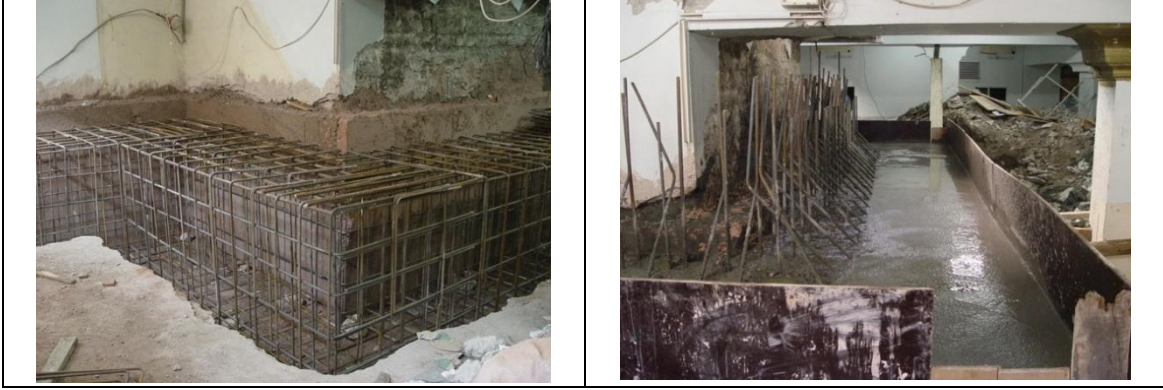
Şekil 10. Kâgir temel sistemine yapılan takviye (Hassa Mimarlık, 2004)
