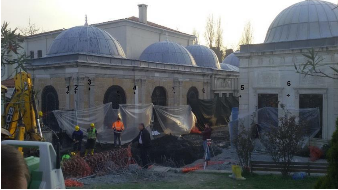
Şekil 5. Terfi Merkezi inşaatı için açılan temel çukuru (Hassa Mimarlık, 2014)
