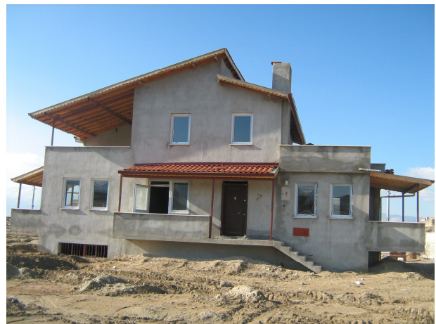
Resim 1. İncelenen Binanın Ön Cepheden Görünüşü
