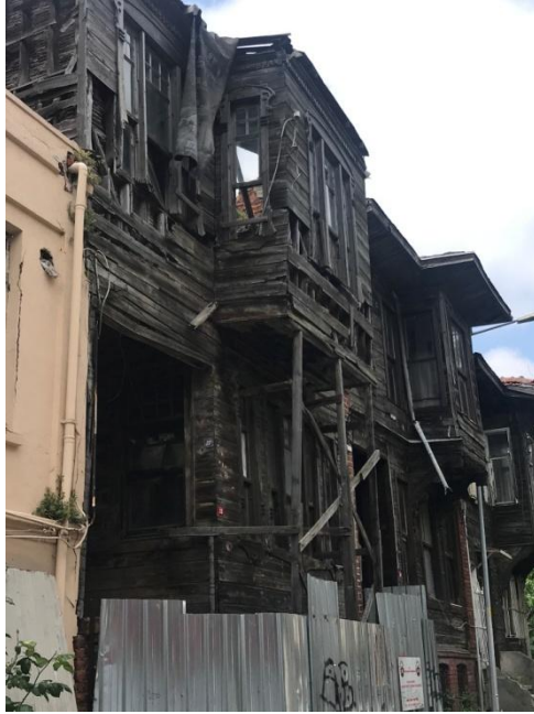
řekil 2. Grnen yapı kalitesi iyi olan yapı
