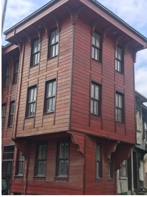
řekil 1. Grnen Yapı Kalitesi İyi Olan Yapı
