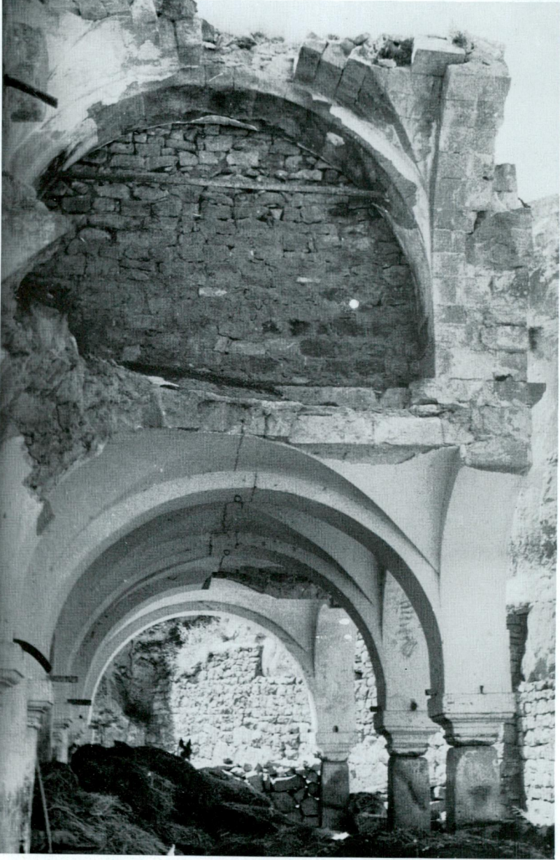
Res. 4 — Germir — Kilise I. Narteksin güneybatı kanadı.
