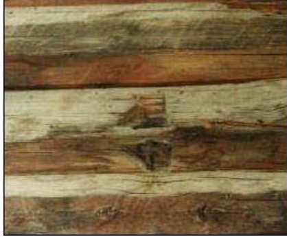
Res. 6- Geyikli Camii, ahşap perde üzerinde açılmış tutacak
