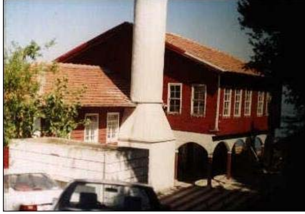
Res. 11- Güde Köyü Camii, genel görünüş
