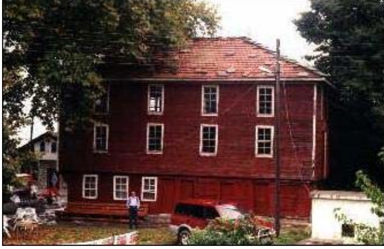
Res. 9- Beldeğirmeni Köyü Camii, genel görünüş
