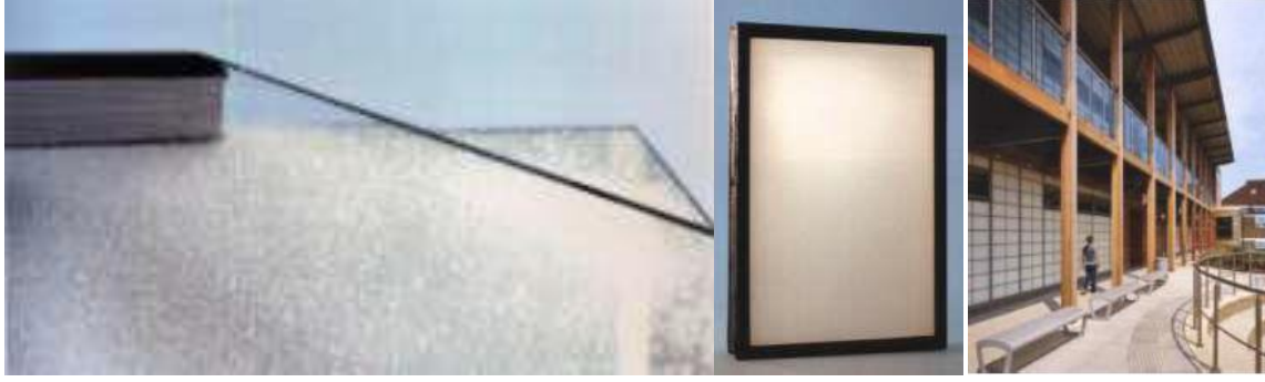
Şekil 7. Aerojel ısı yalıtım malzemesinin Londra'daki okul eklentisinin cephesinde kullanılması [22].
