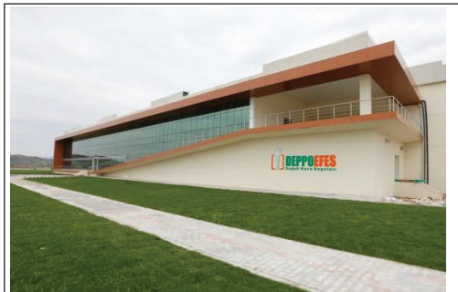
Resim 1. Selçuk Belediyesi Deppo EFES Soğuk Hava Deposu
