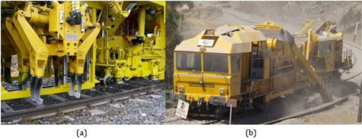
Şekil 4. Demiryolu hattında buraj (a) ve balast eleme makinası (b) çalışması
