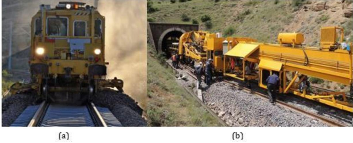
Şekil 3. Demiryolu hattında regülatör (a) ve hızlı yol yenileme makinası (b) çalışması
