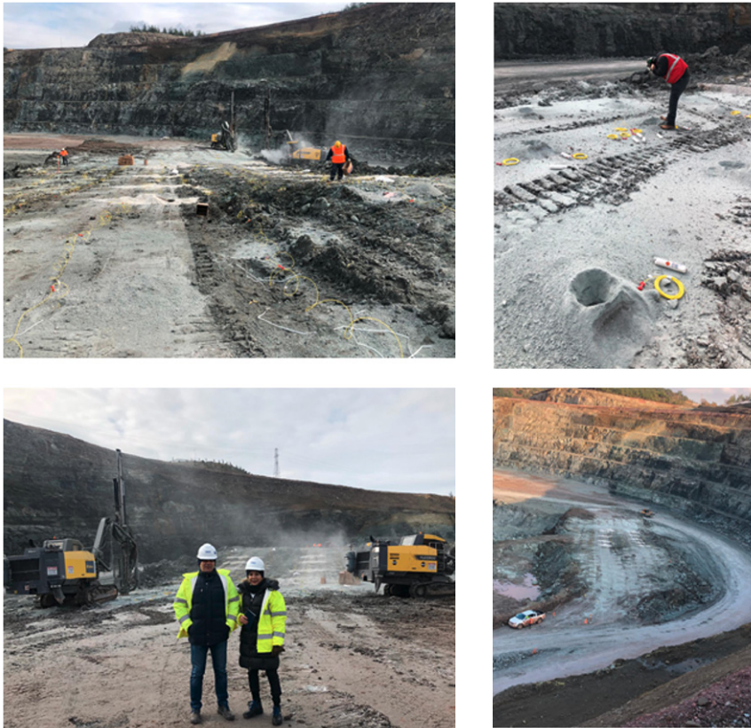
Şekil 2. Patlatma yapılacak alandaki delme-şarjlama çalışmaları
