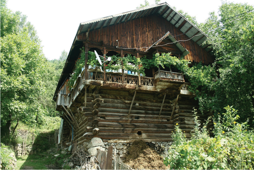
G. 8: Yığıma taş duvar üstü ahşap yığıma tekniği ve üzerinde ahşap çatma tekniği, Artvin, Şavşat (Kaynak: Selim İhtiyar Arşivi)
