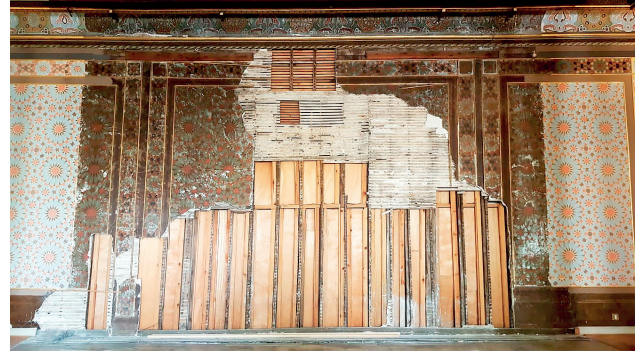
10 Tablonun arkasında kalan duvarın görünümü
