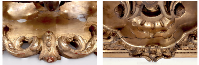
12 Çatlaklar ve motif kaybı
