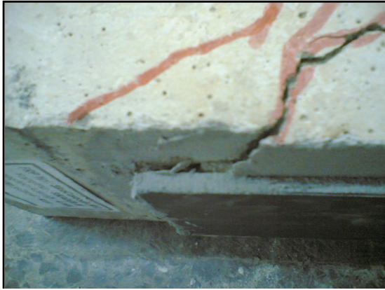
Şekil 4. B09 deney elemanı- FRP uç kısmında ayrışma ve betonda çatlaklar.
